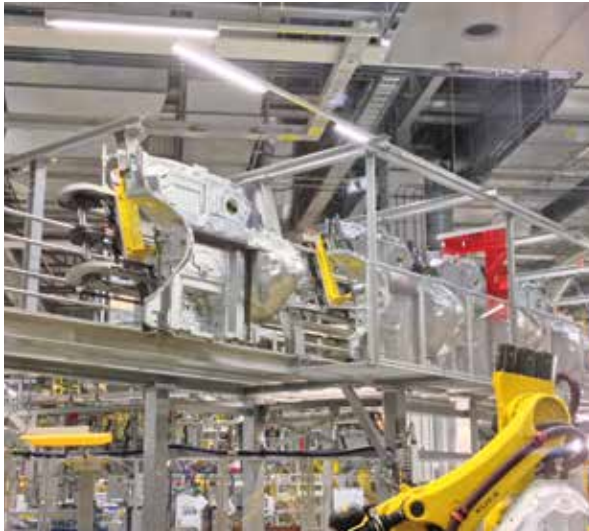
Ein Stauförderbänder für den Transport der Bodengruppe
