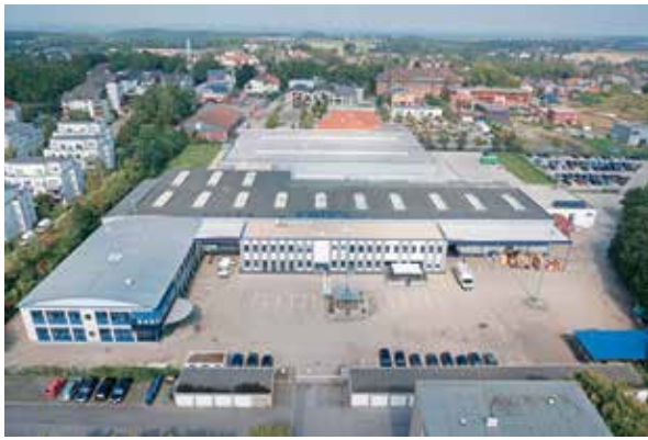
Blick auf das Firmengelände
